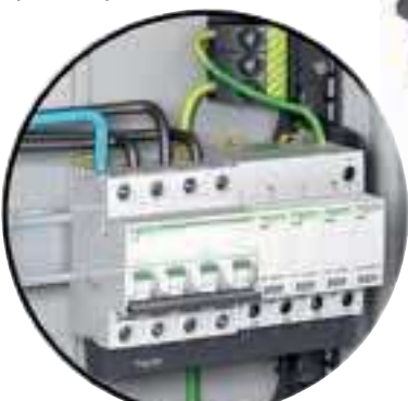
Ogranicznik przepięć iPRD 4P + iC60N 4P
